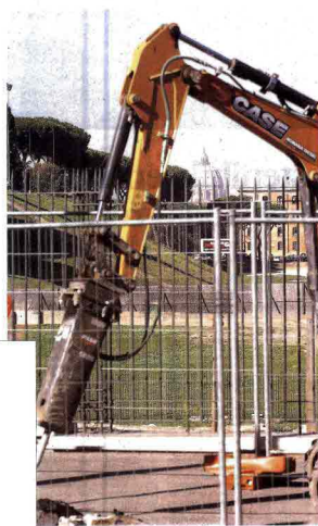
Lavori in corso. Un cantiere a Roma per il Globale. FOTO: ANSA
